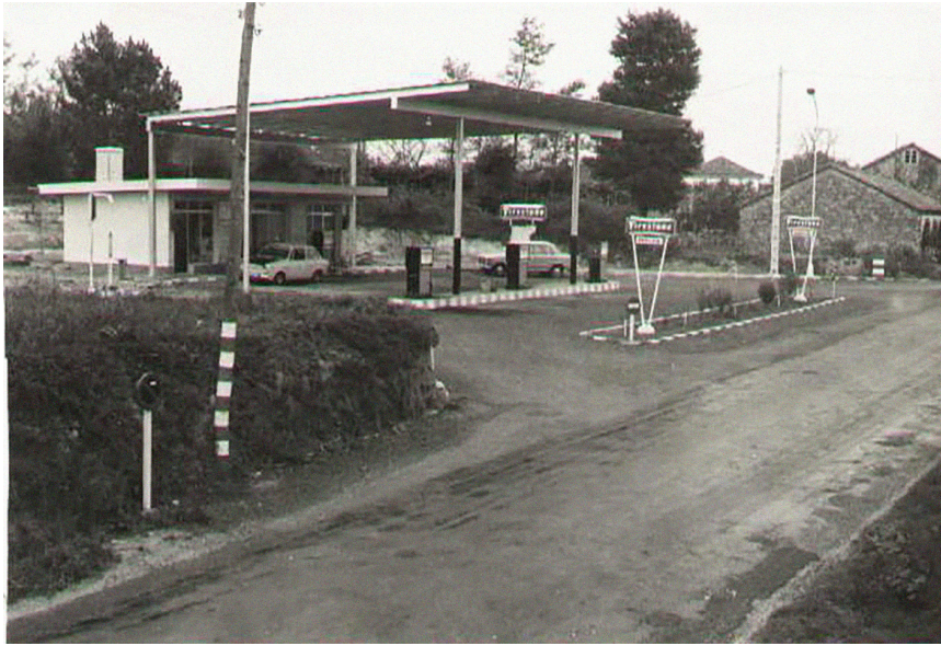
Estación de servicio Los Ángeles Gas en Brión, Santiago de Compostela, 1973.
